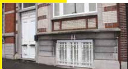
**Soubassement :** le soubassement est la partie inférieure d'une construction, qui sert d'assise au bâtiment. À Charleroi, le soubassement est souvent en pierre bleue. La fenêtre d'un soubassement s'appelle un **soupirail**.
